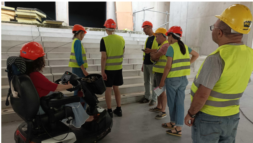
Le Collectif T'Cap et ses experts d'usage en visite sur le chantier de Mixt
